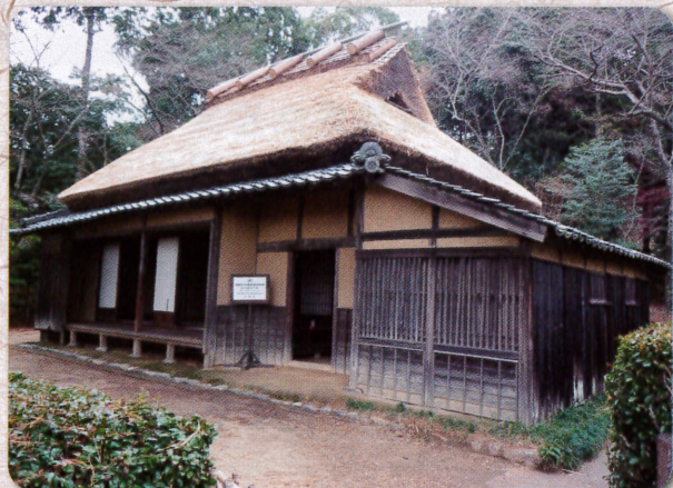
茅葺き屋根修理工事が完了した柳田國男生家
