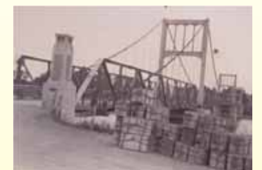
建設中の栄橋 個人蔵
